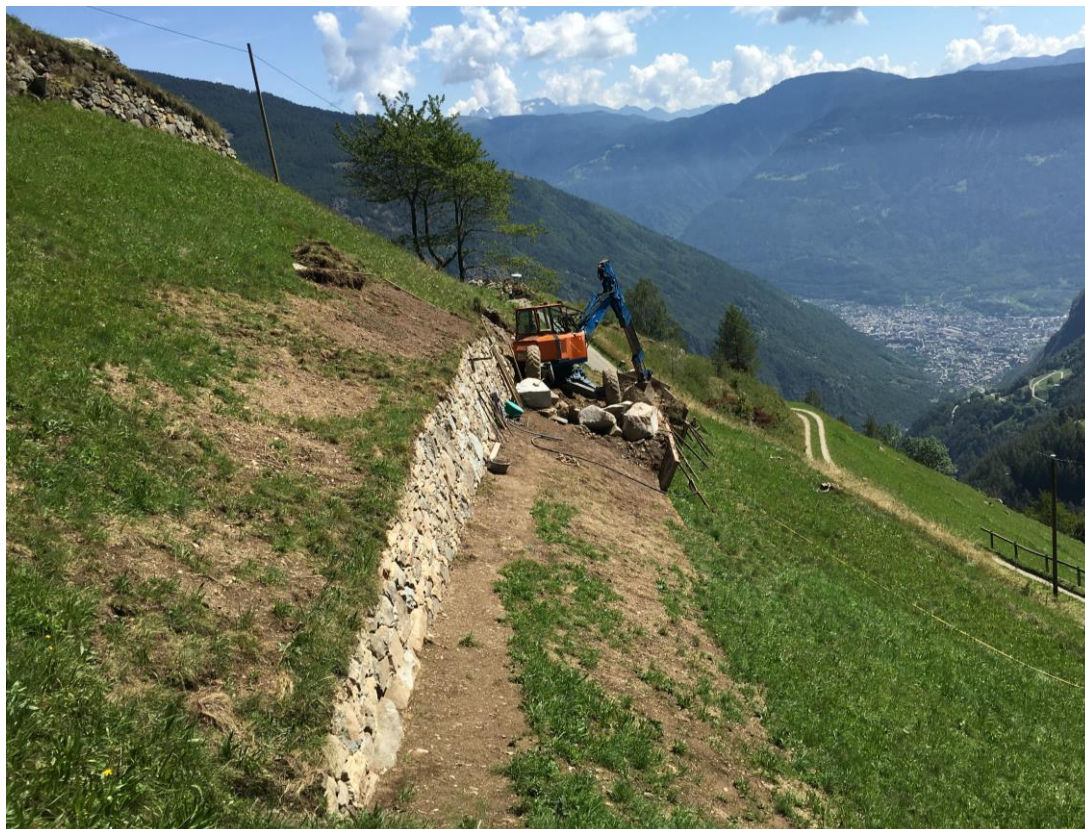
Arbeiten im steilen Gelände durch das Baukonsortium Pianta – Pola
