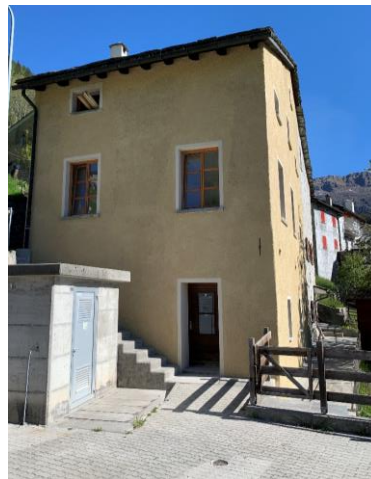
Nach die Renovierungsarbeiten
